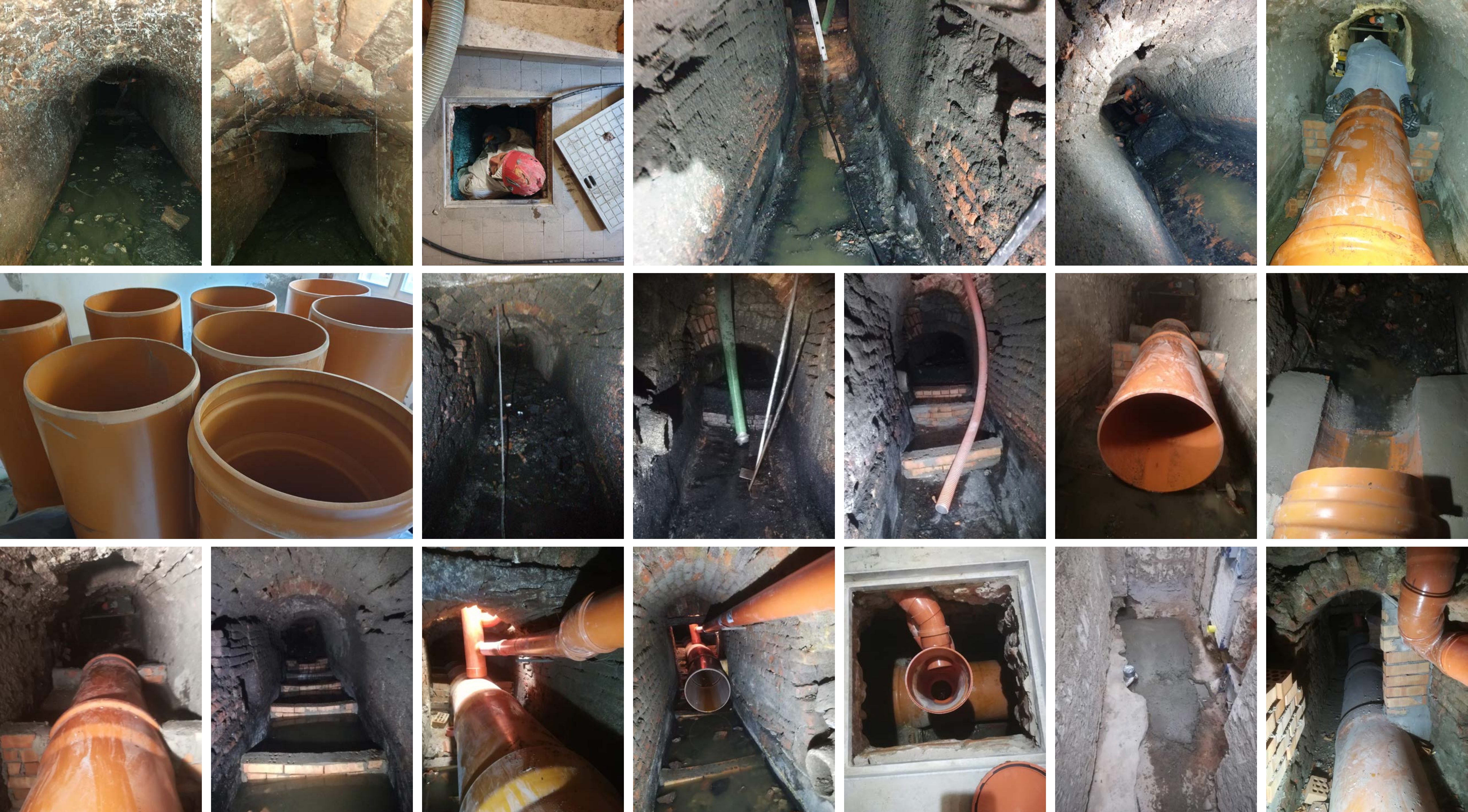
Direzione lavori rifacimento ed adeguamento fognatura Bologna (BO) – Committente Condominio
