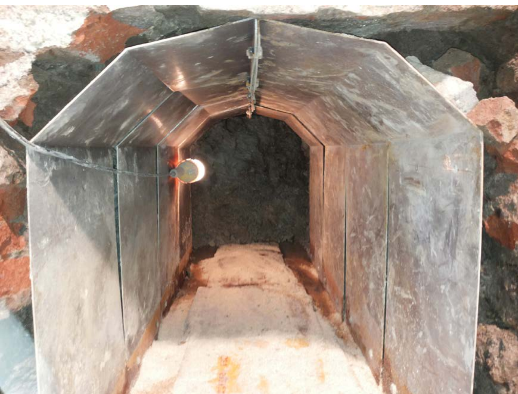
Rilievo, adeguamento e regolarizzazione impianto fognario con scavo in galleria Casalecchio di Reno (BO) – Committente Condominio
