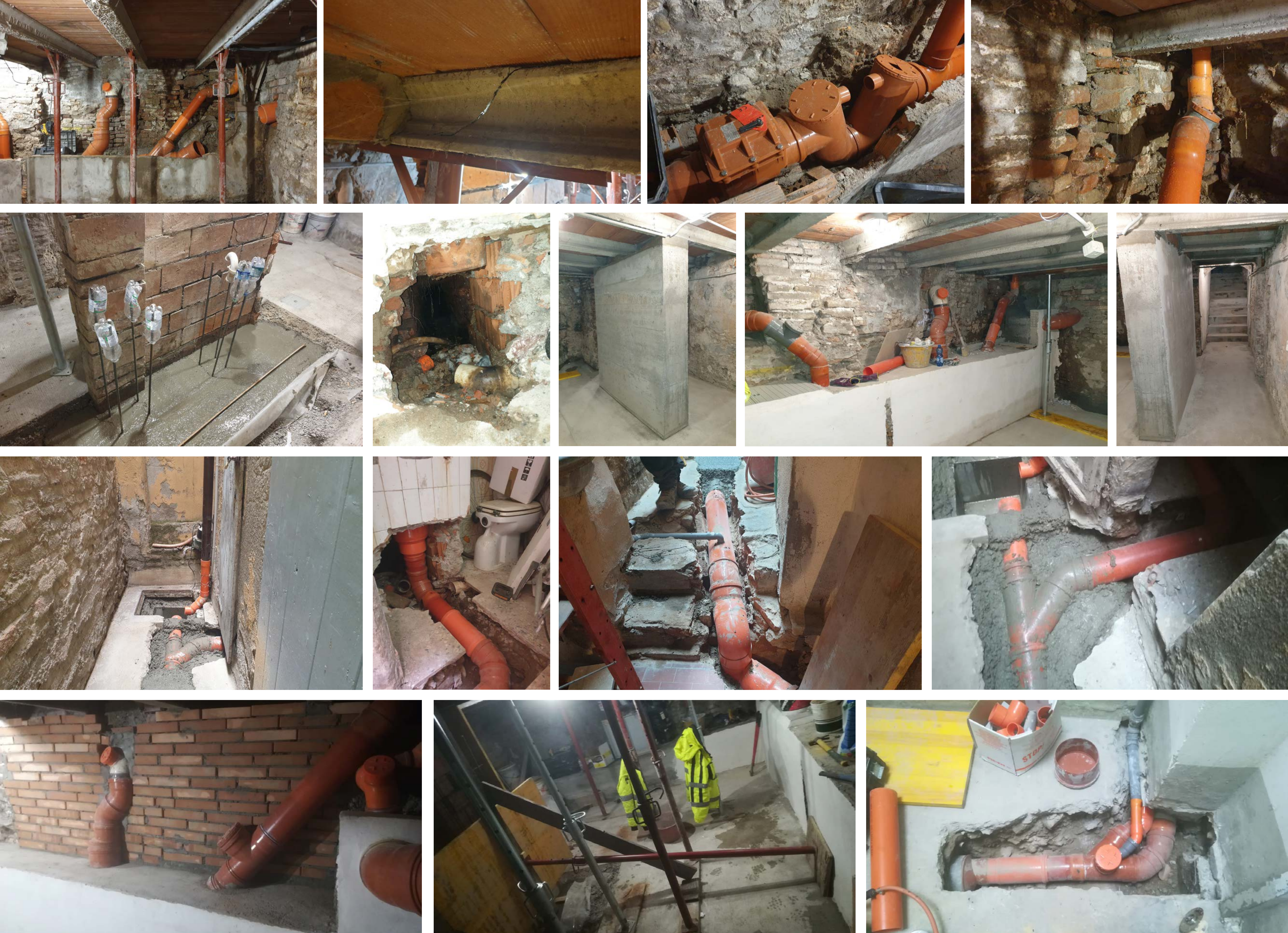
Direzione lavori regolarizzazione fognature e consolidamenti strutturali murature Bologna (BO) – Committente Condominio
