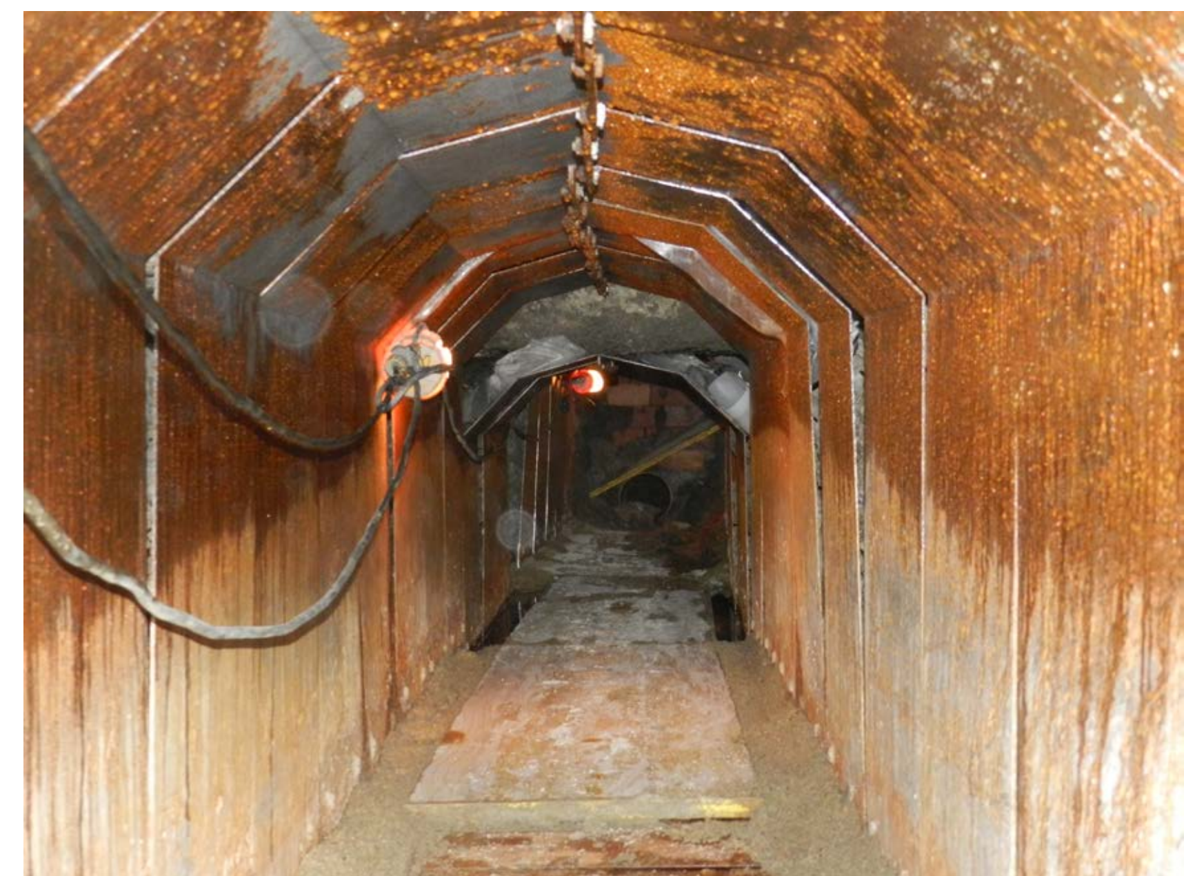
Rilievo, adeguamento e regolarizzazione impianto fognario con scavo in galleria Casalecchio di Reno (BO) – Committente Condominio
